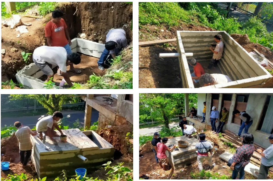
Gambar 6. Kegiatan pemasangan beton precast secara bertahap untuk pembuatan septictank
