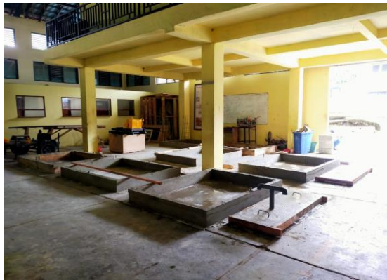
Gambar 5. Pengecoran 7 beton precast dan 4 plat penutup septictank
