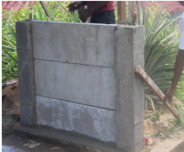
Gambar 4. Penyetelan Kolom dan Dinding Plat
