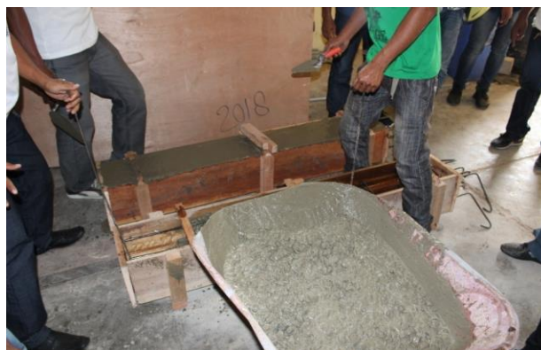
Gambar 3. Pengecoran Kolom Beton Precast
