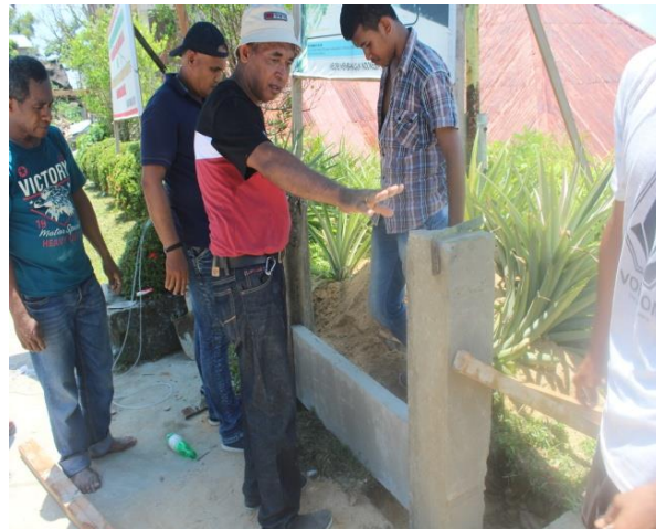
Gambar 5. Pemasangan Kolom dan Dinding Plat
