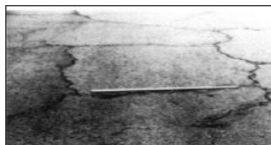
Gambar 2. Retak Kotak - Kotak
