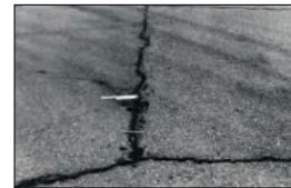
Gambar 4. Retak Sambung
